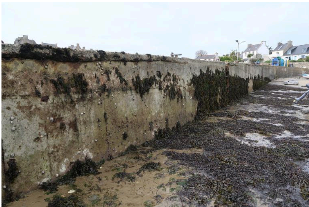
Cale de porz Kernog, côté est (ciment et échelle)
