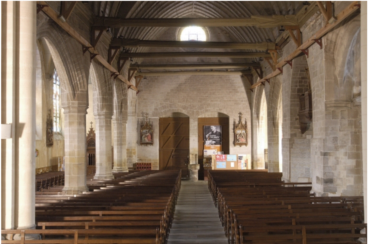
Vue intérieure, prise du chœur vers la nef
