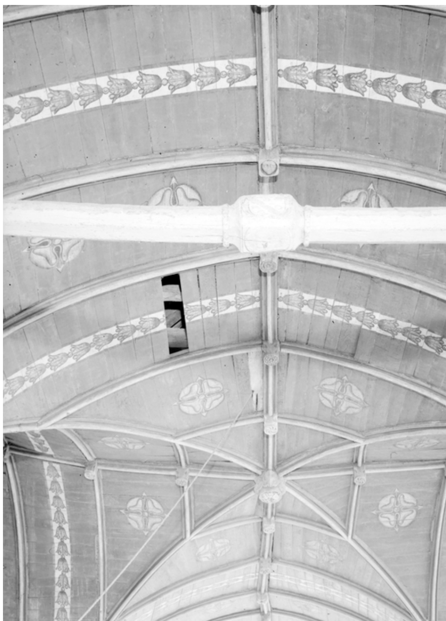
Voûte lambrissée de la nef : détail de la croisée du transept
