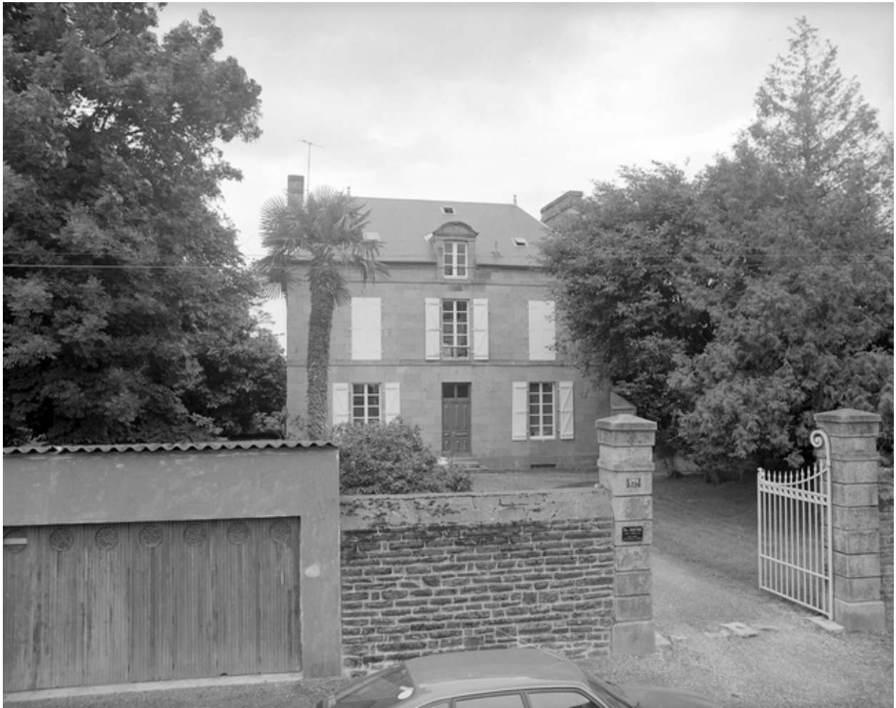
Elévation nord, vue générale.
