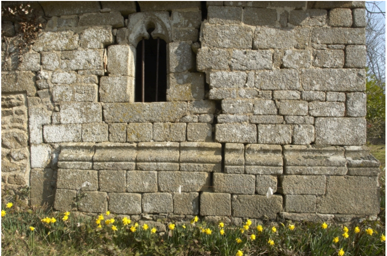
Détail de la maçonnerie de la chapelle
