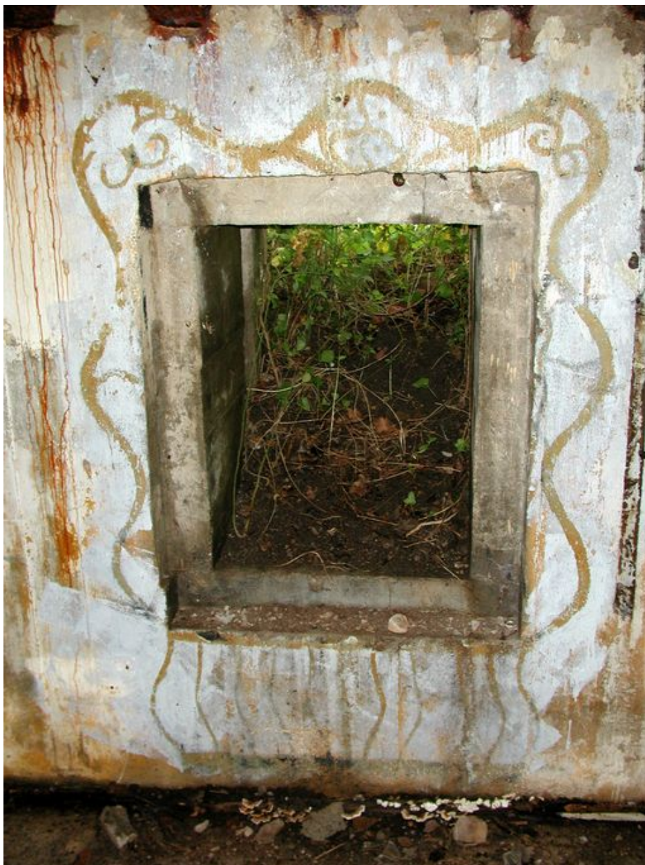
Vue intérieure : sortie de secours (état en 2003)
