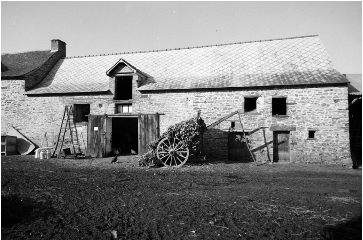
Dépendances, façade, partie est.
