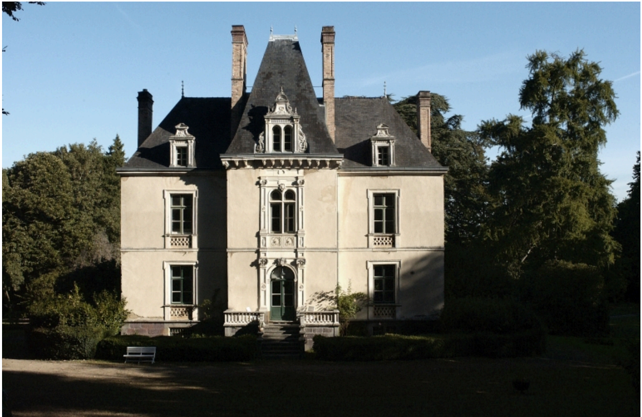
Vue générale de la façade sud
