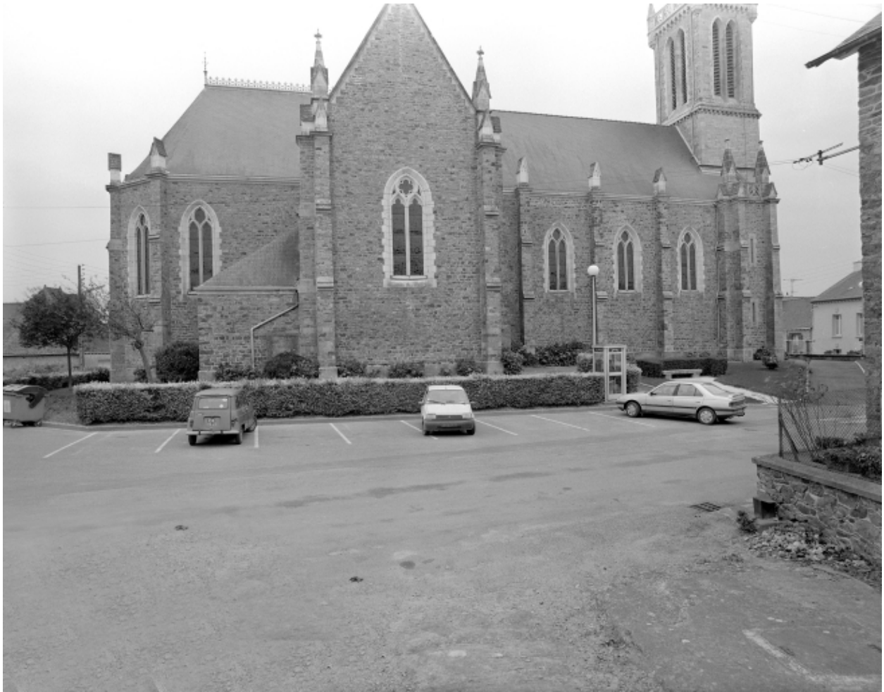
Élévation nord : vue générale
