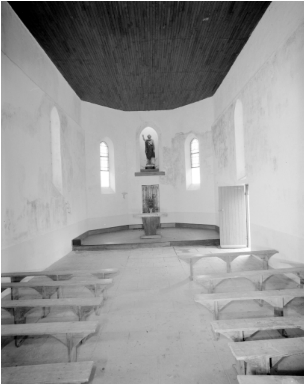
Intérieur : vue générale vers le chœur.
