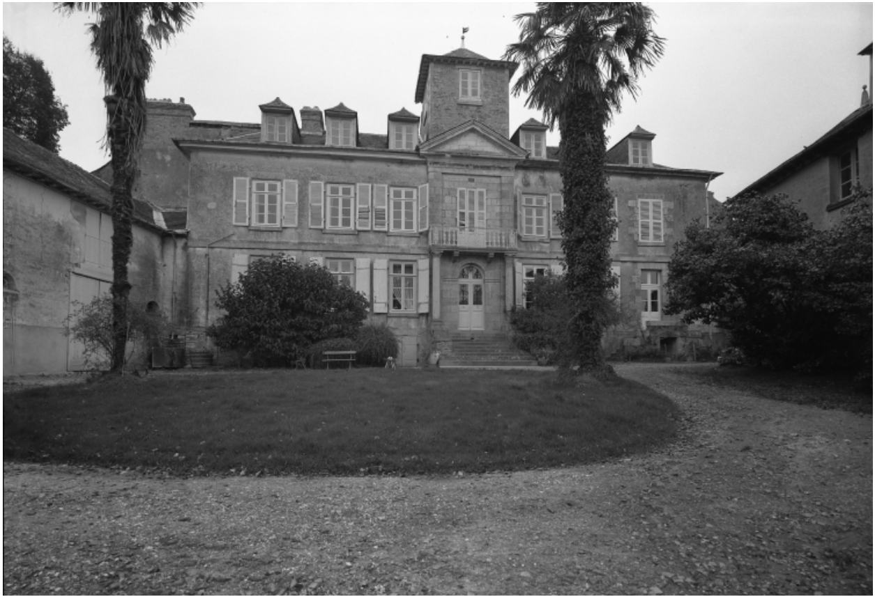
Elévation sud, vue générale.
