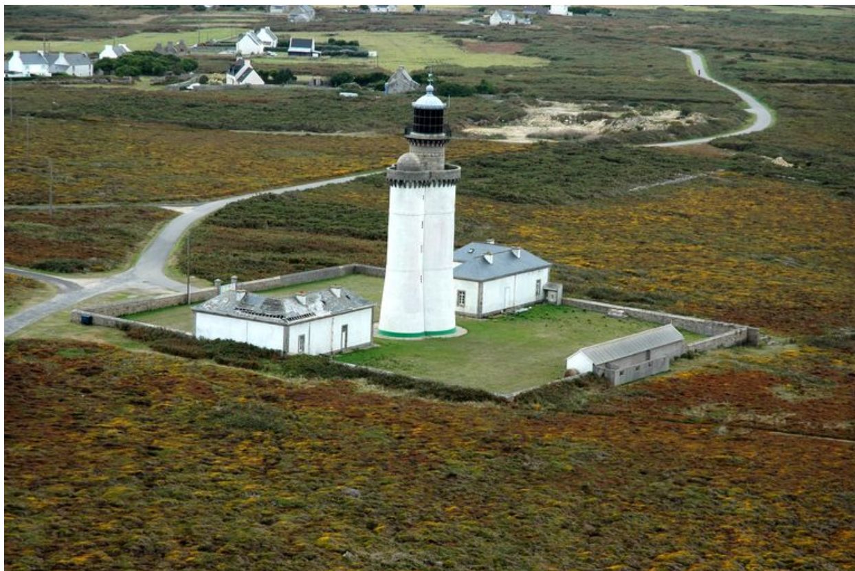
Vue générale du phare du Stiff et de ses parties constituantes
