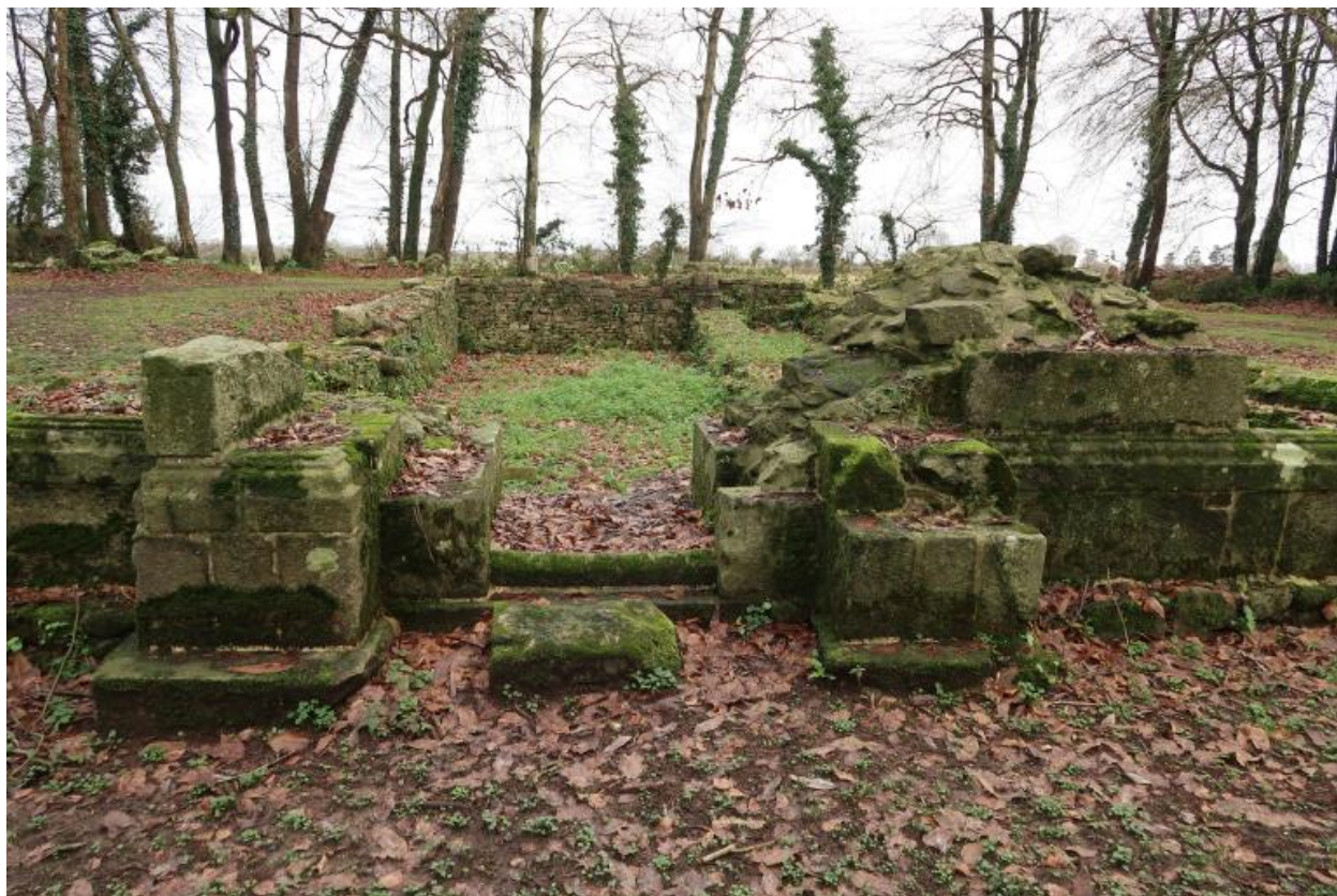
Vue du mur ouest. De part et d'autre du portail, vestiges des contreforts en "I" du mur-pignon soutenant le clocher
