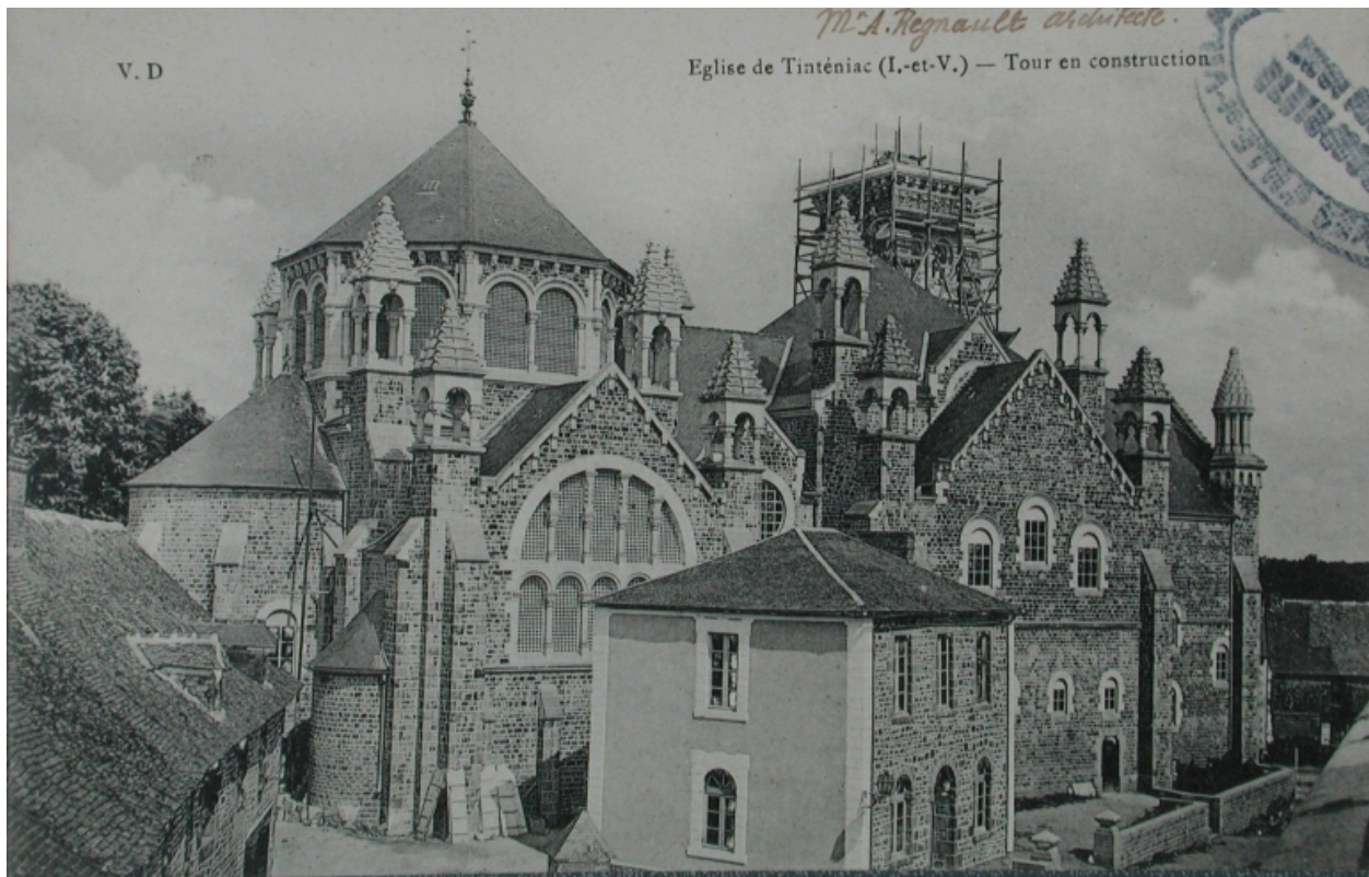
Construction du clocher
