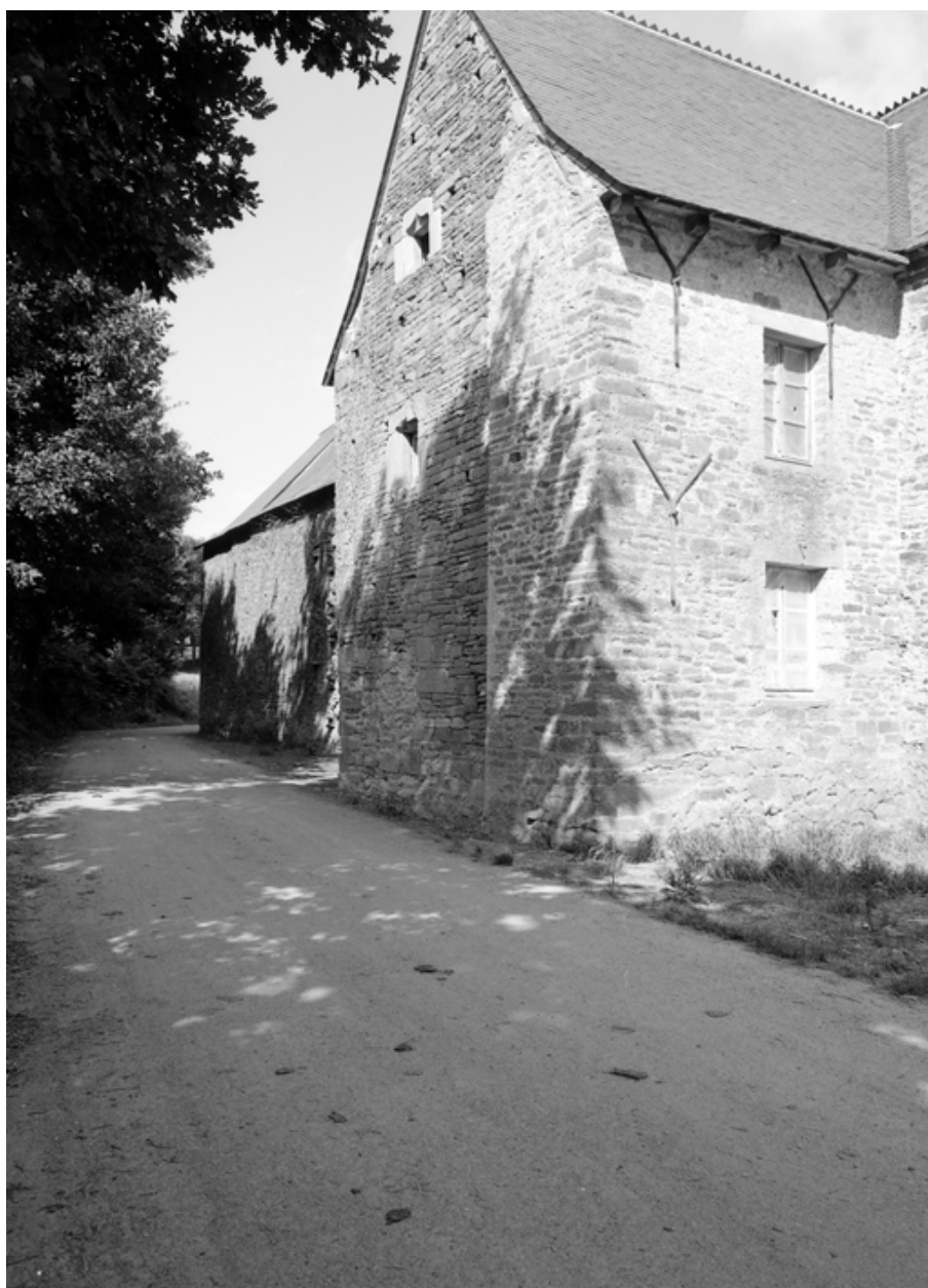
Vue de l'angle de la façade nord-ouest
