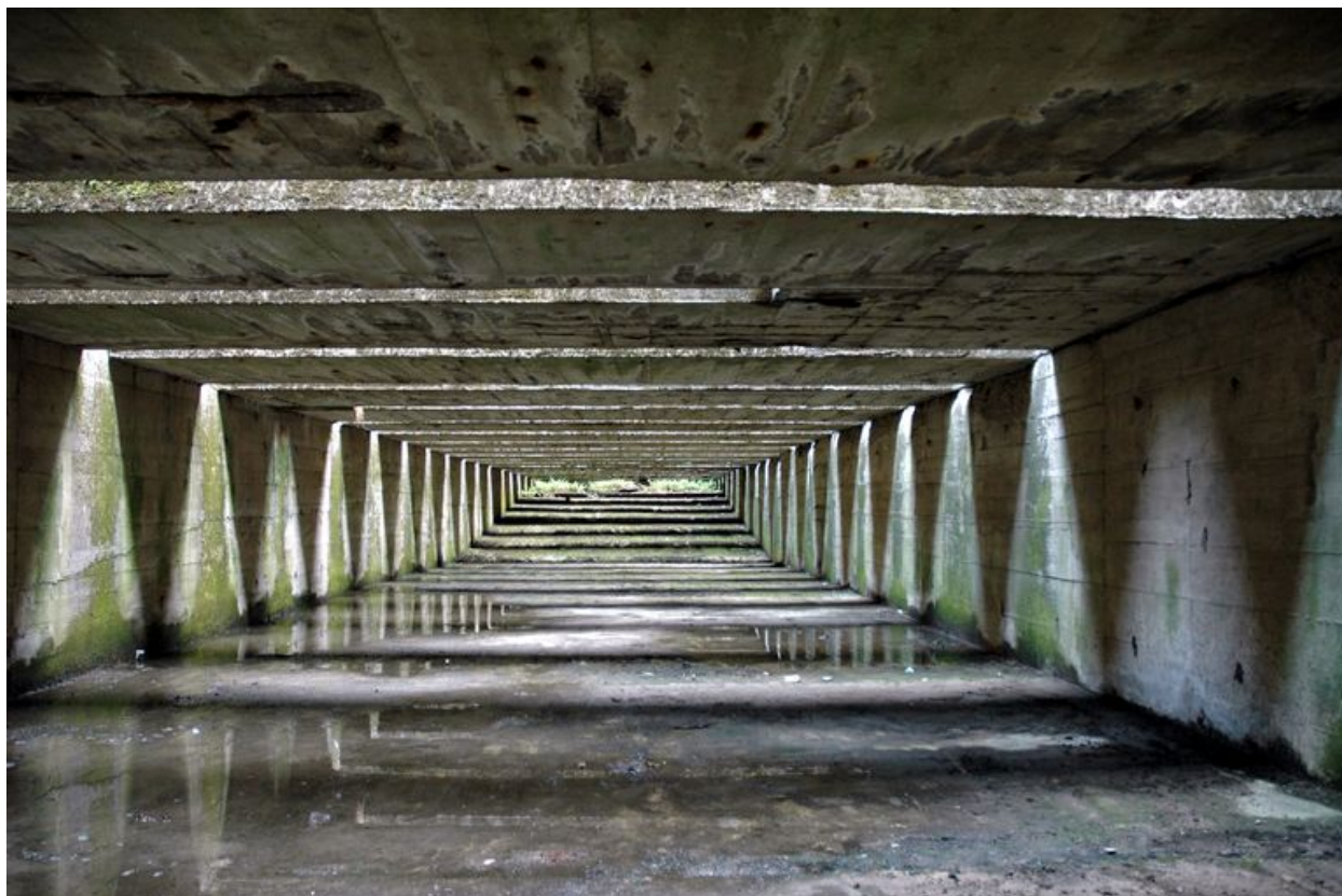
Vue de la chambre d'explosion sous la structure de type Fangrost
