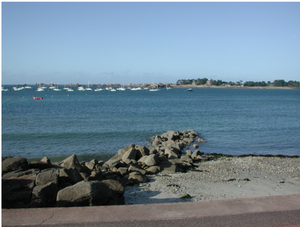
Vue d'un enrochement en épi perpendiculaire à la digue-Promenade
