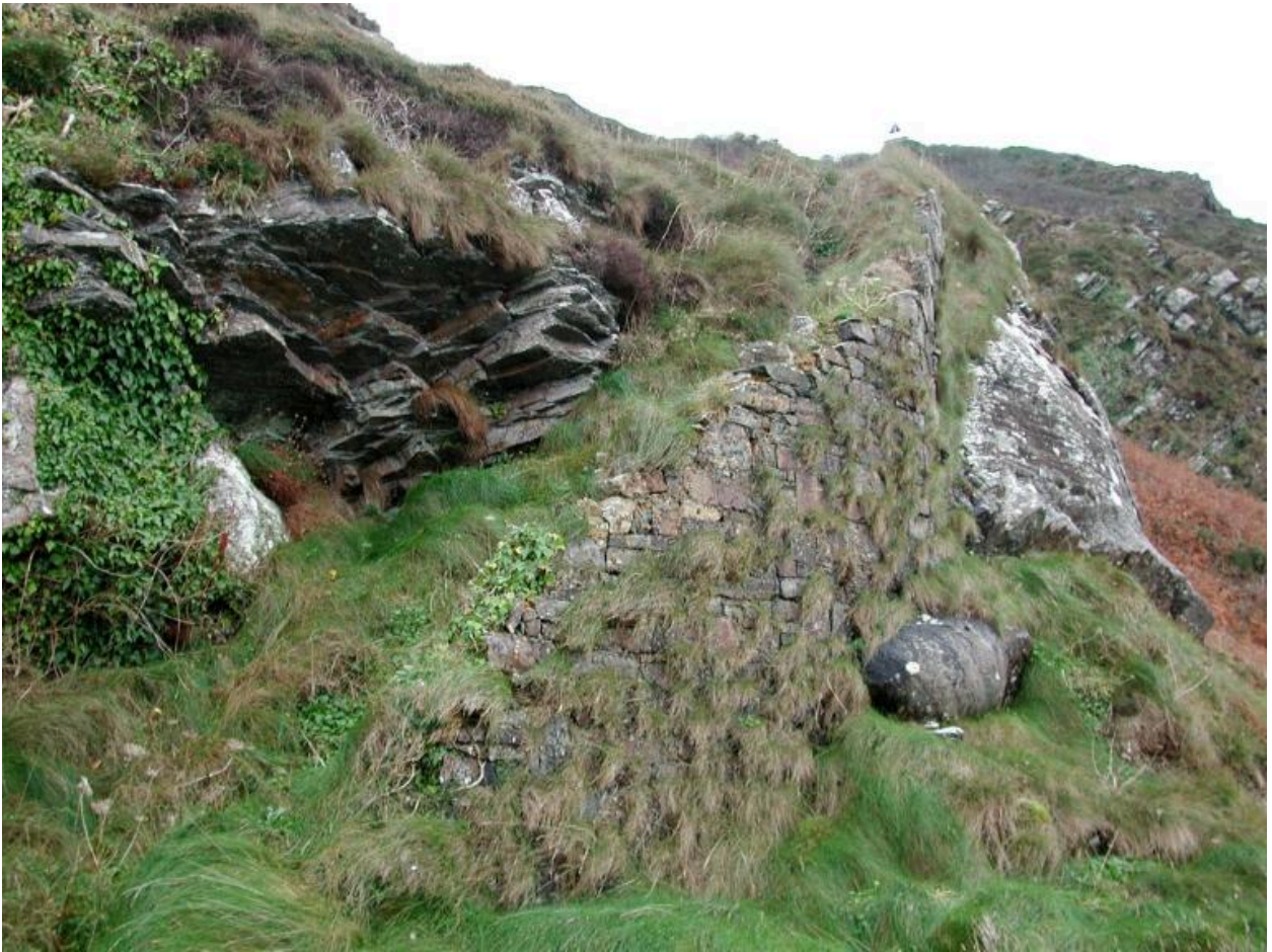
Vue de l'escalier d'accès avec son mur de soutènement (état en 2001)
