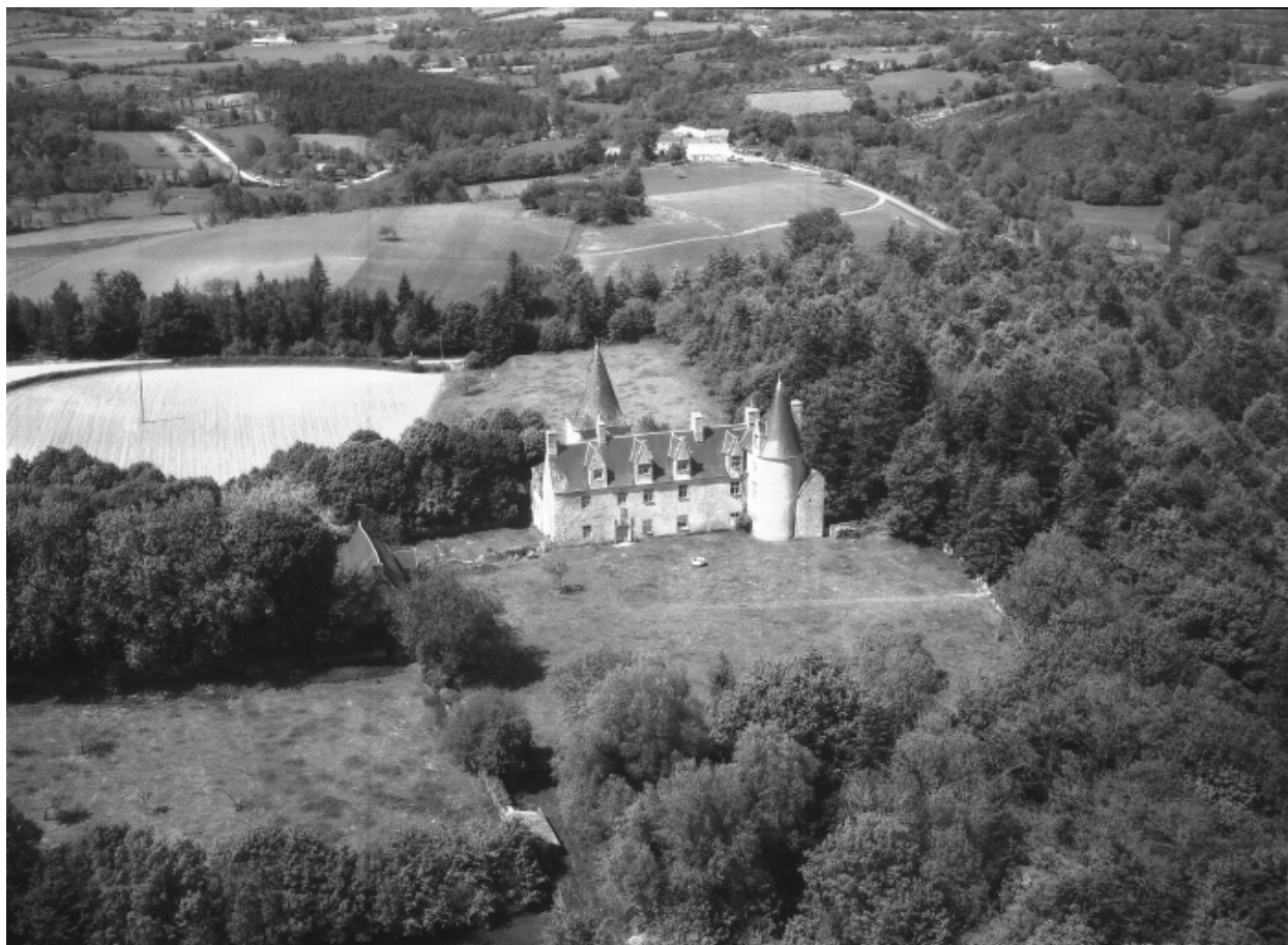
Vue générale prise du sud
