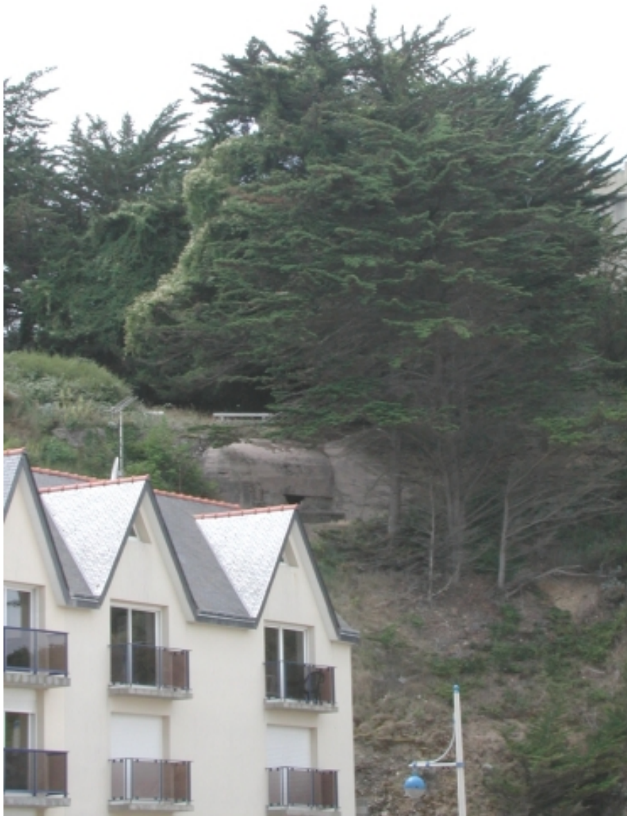
Vue de situation dans la falaise de la digue-promenade des Murs-Blancs (état en 2003)
