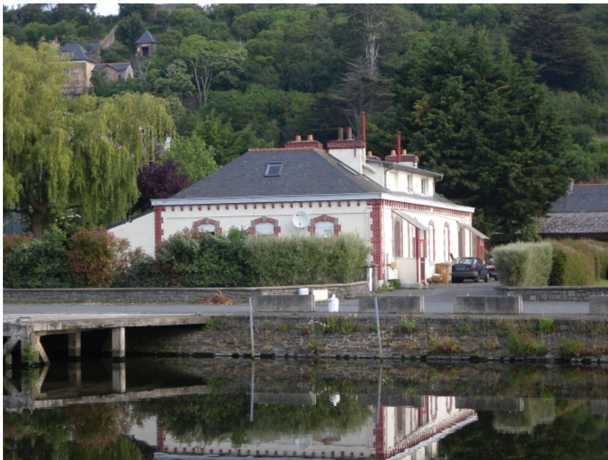
Vue générale de la façade Nord
