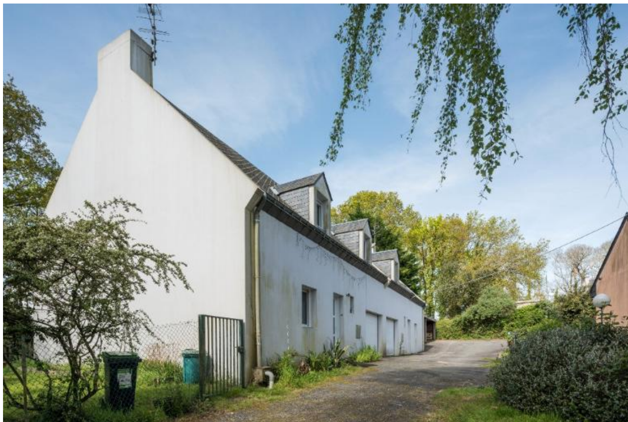
Façades nord-est des logements.
