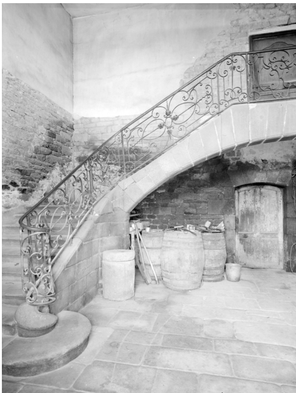
Vue générale de l'escalier, état en 1967
