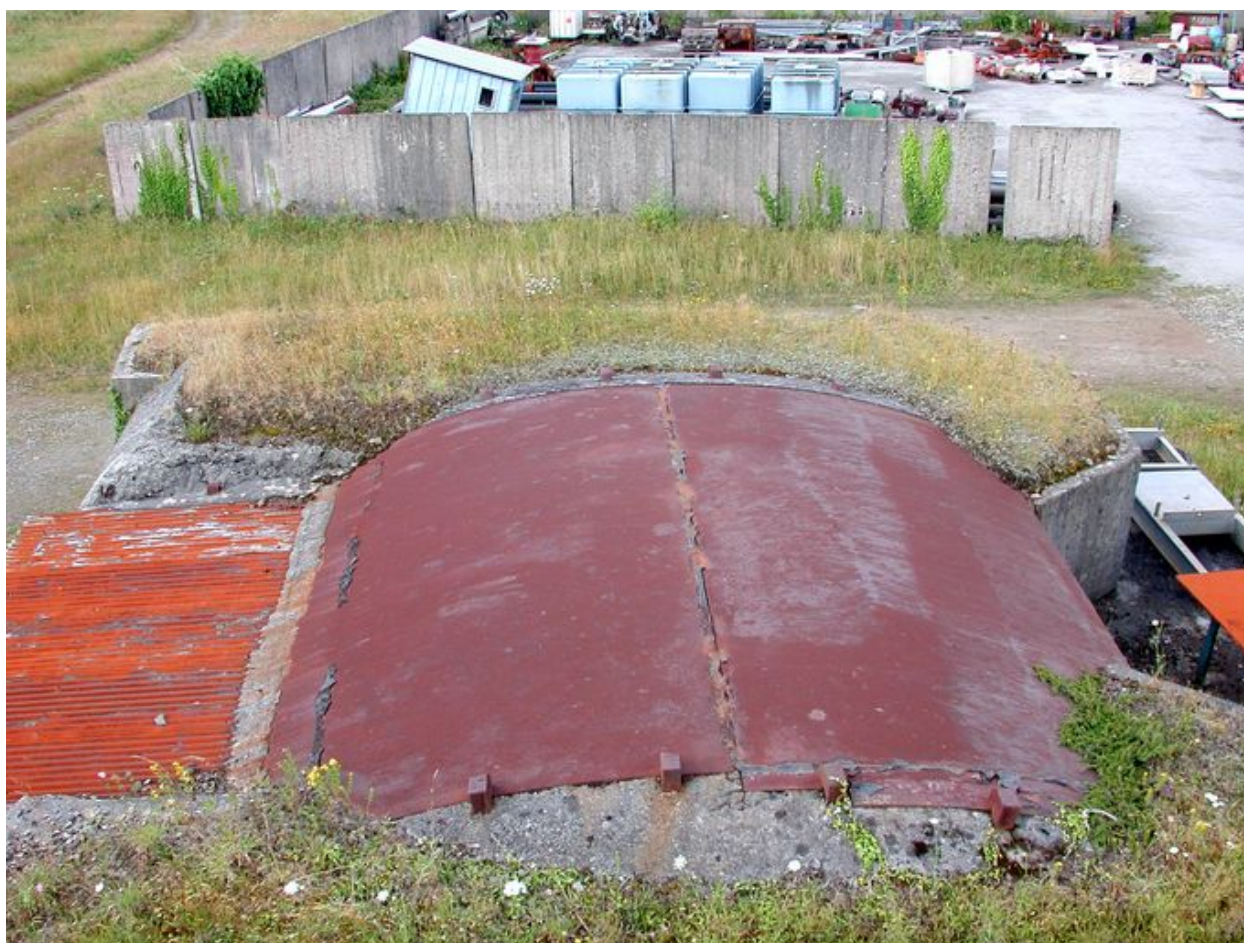
Vue du toit blindé (état en 2003)
