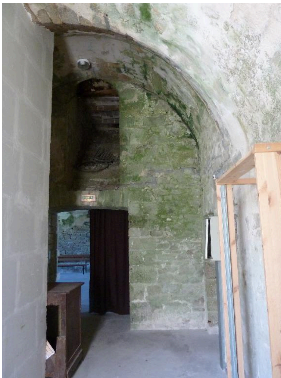
Hoedic, fort central, caserne à l'épreuve, escalier vers la terrasse.
