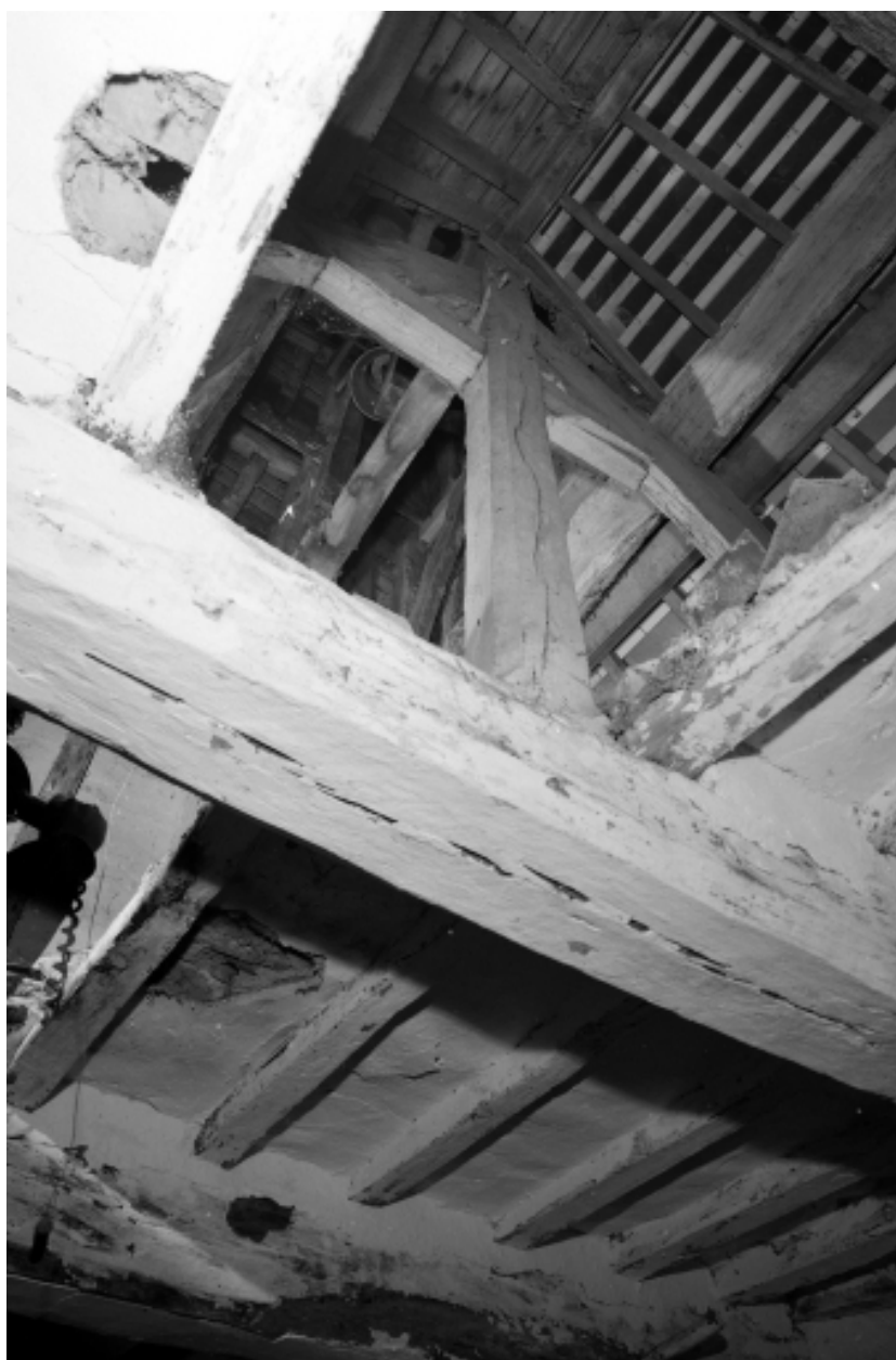
Intérieur : détail de la charpente.
