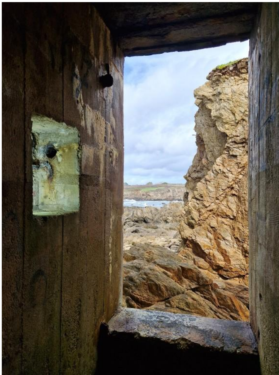
Vue intérieure : accès nord (entrée est). A gauche, niche murale
