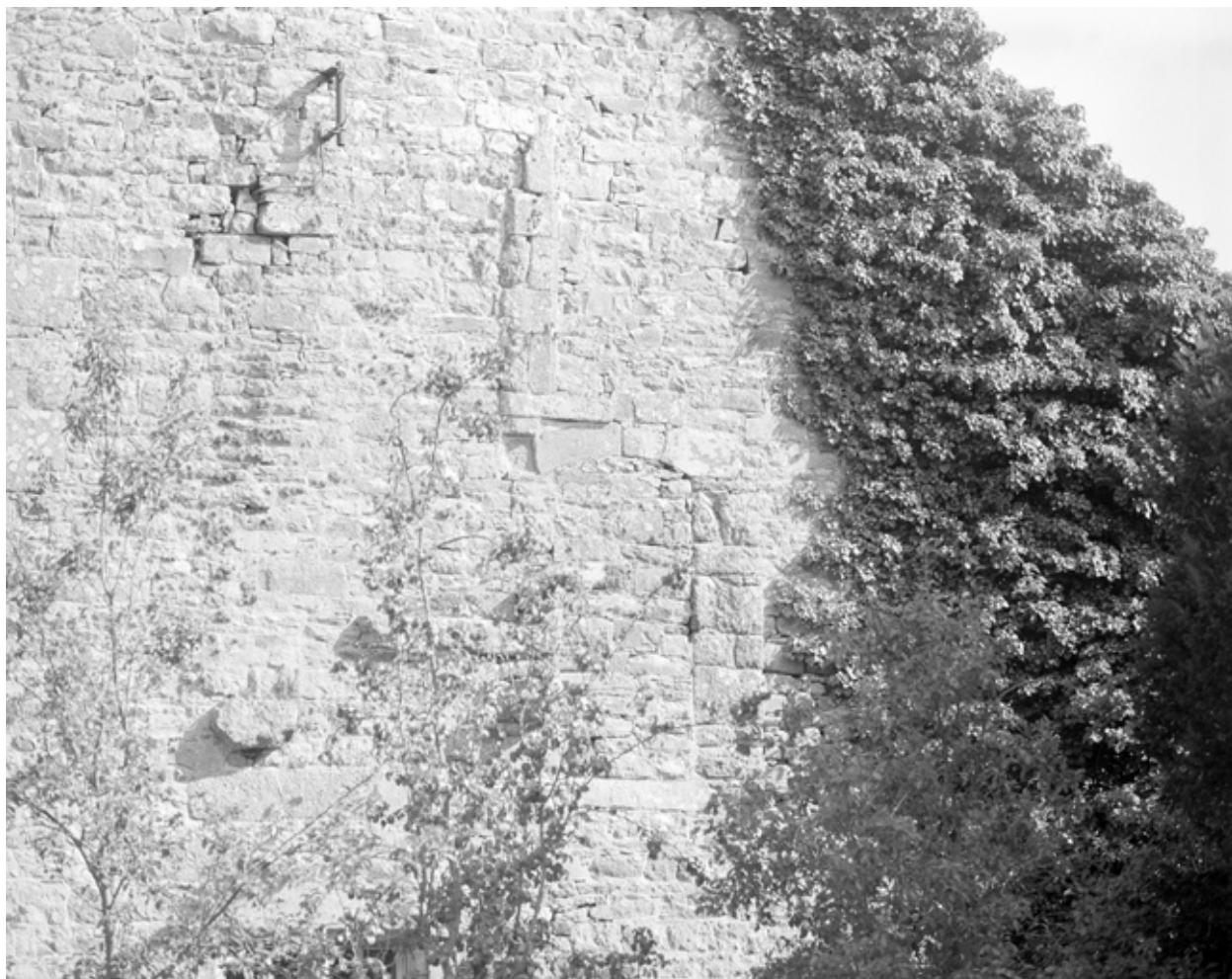
Face sud : ouverture bouchée
