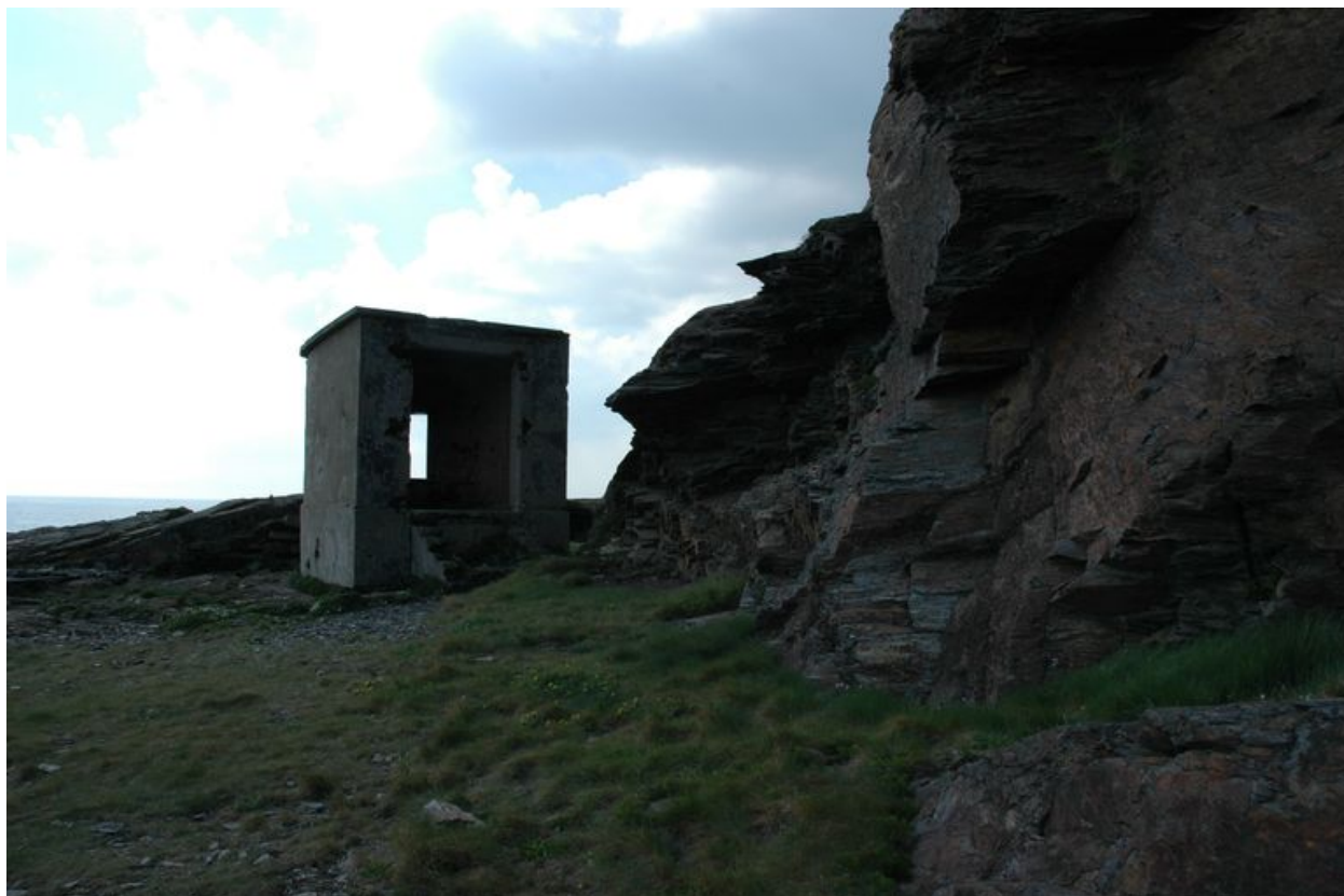
Vue générale d'un abri en moellon de 45 cm d'épaisseur pour installation photo-électrique
