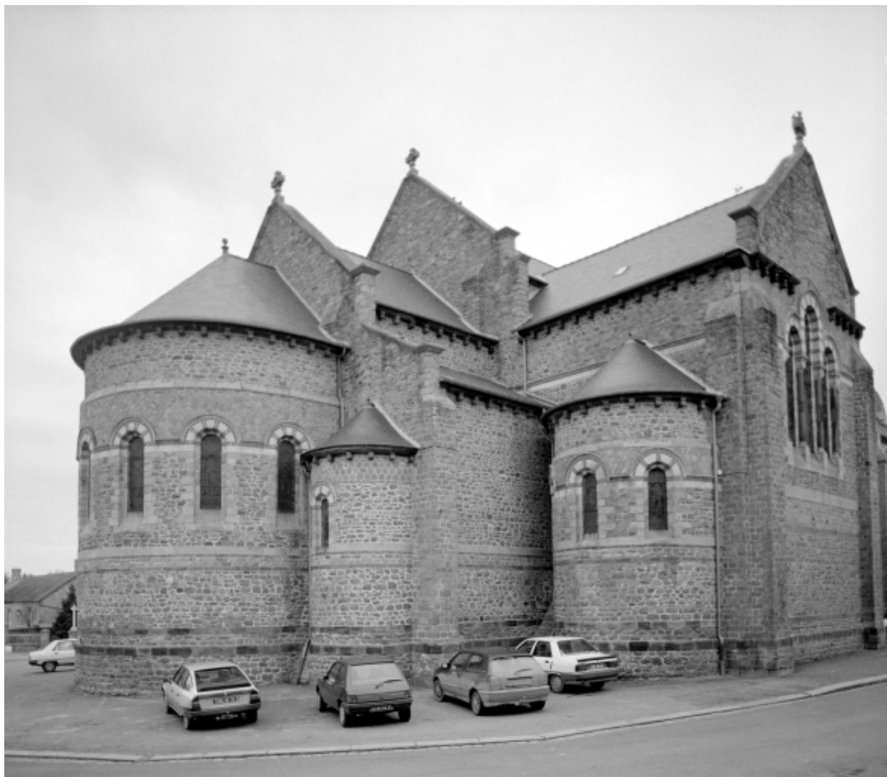
Elévation Sud-Est : vue générale
