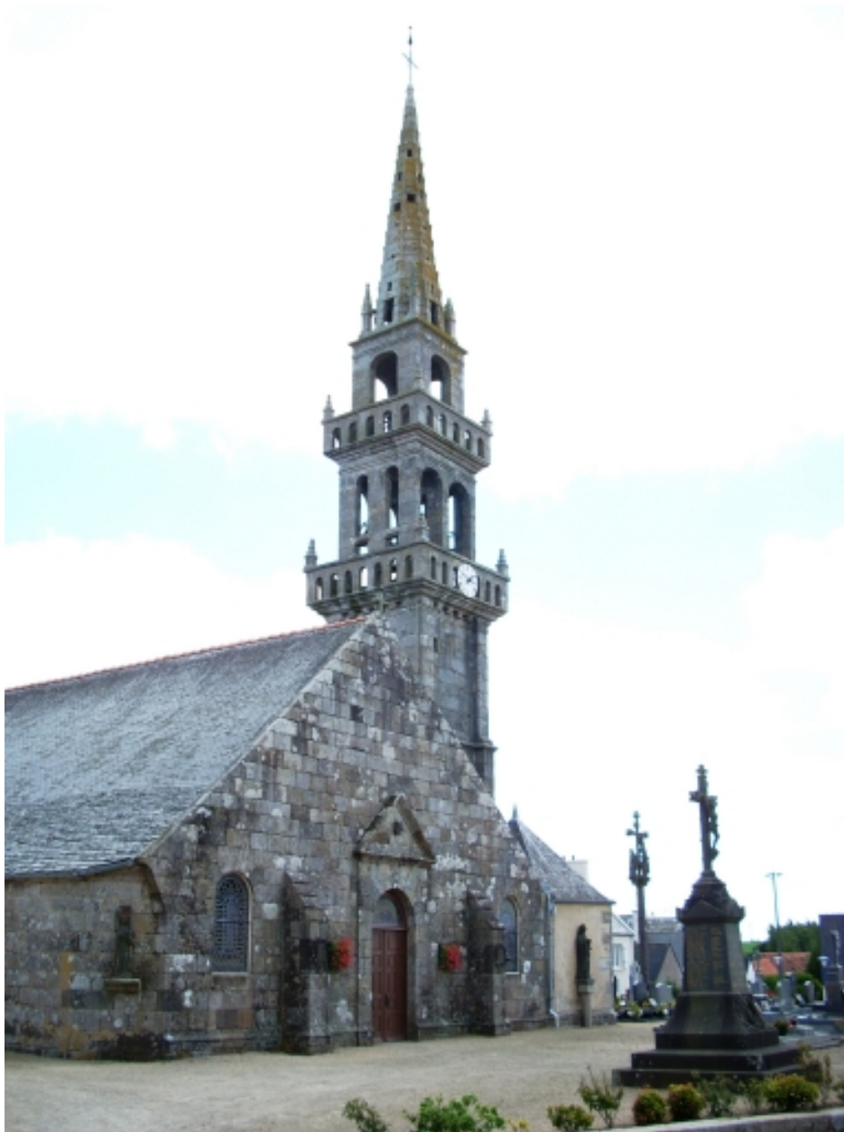
Saint-Vougay, église paroissiale Saint-Vougay : vue générale nord-ouest
