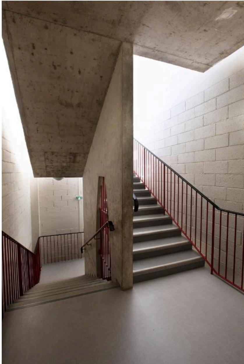
Cage d'escalier : béton et garde-corps métalliques, main-courante de la rampe en PVC.
