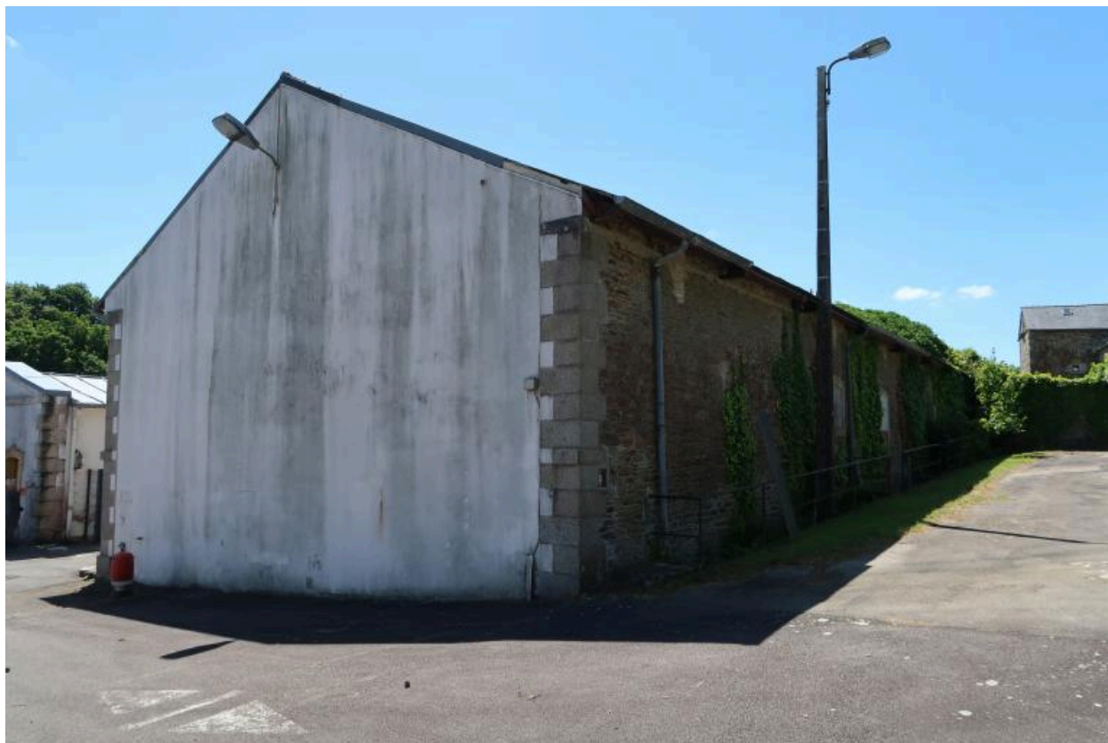
Vue générale : élévation nord non enduite (état en 2022)
