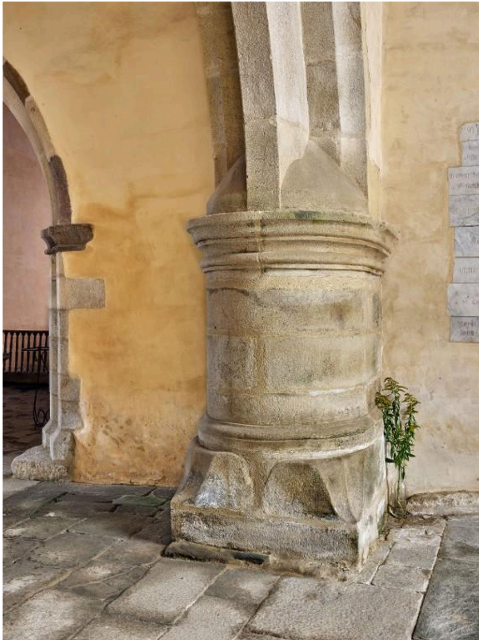
Puissant pilier du transept sud
