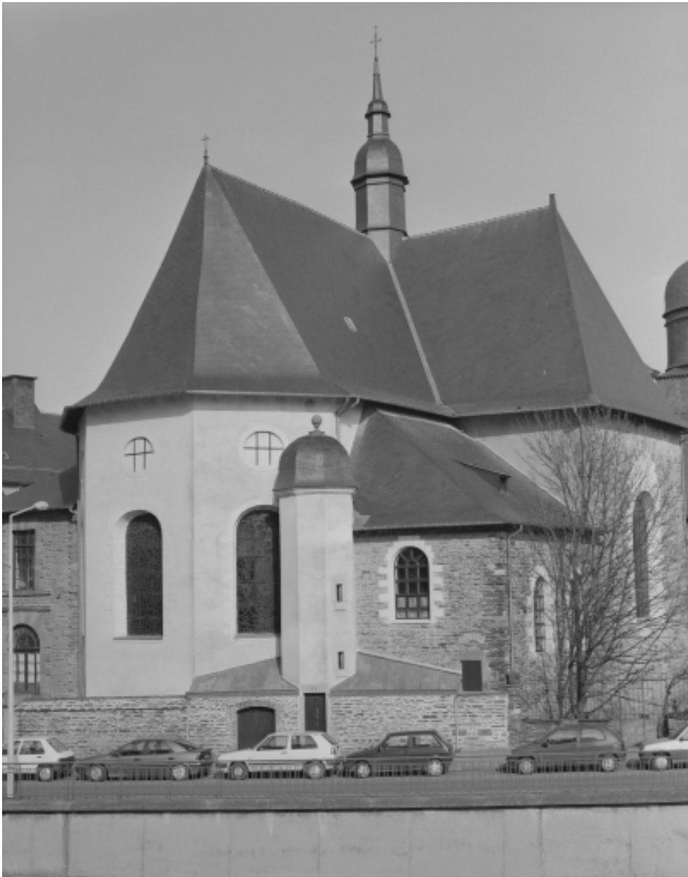
Elévation Ouest : vue générale
