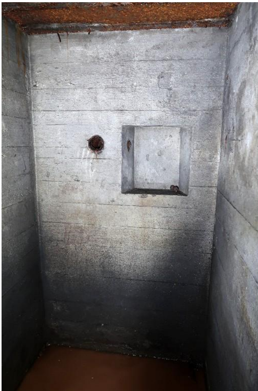
Vue de la petite salle située au nord-est : mur du fond avec niche murale et passage de câble
