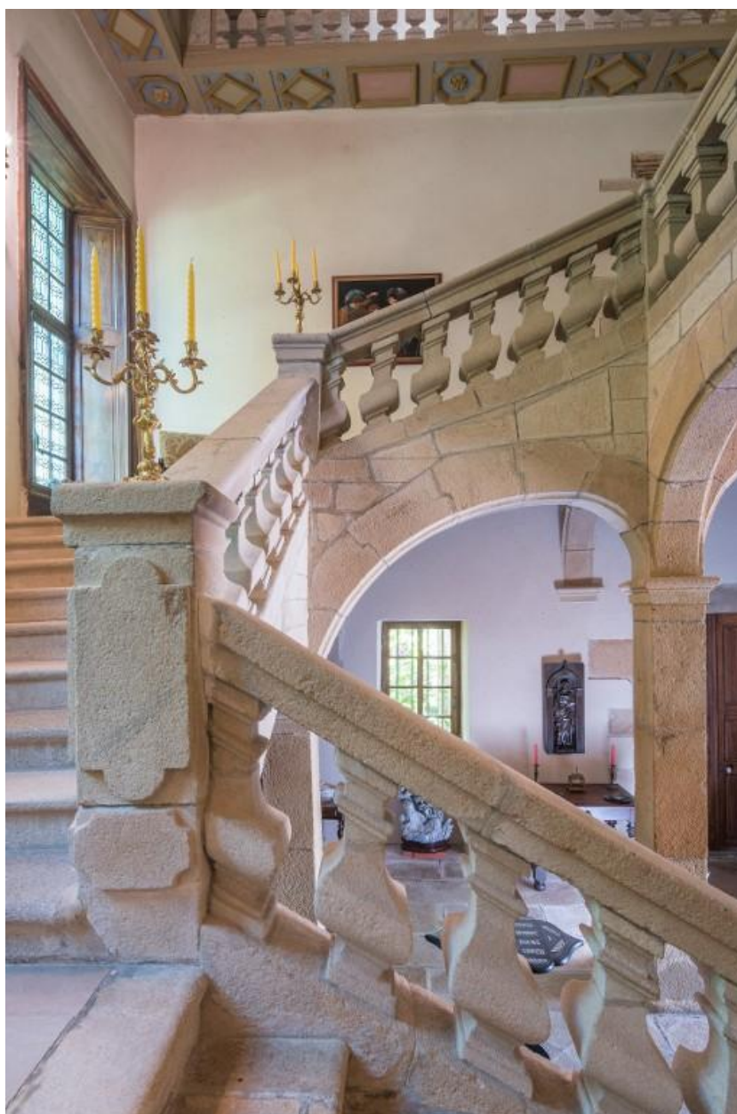
Escalier monumental: détail des balustres à section carrée
