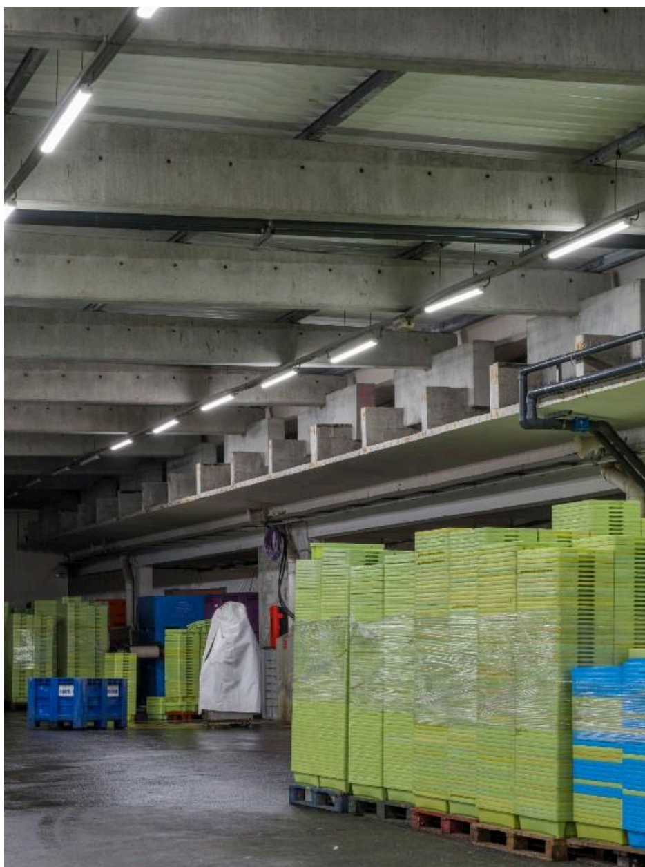
Zone des caisses empilées et détails des poutres béton et leur succession
