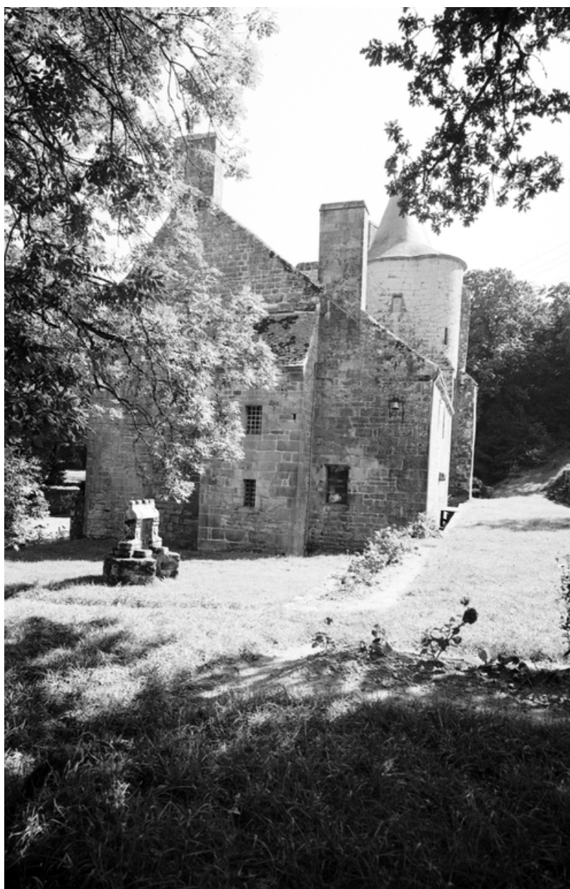
Logis, élévation nord : vue générale
