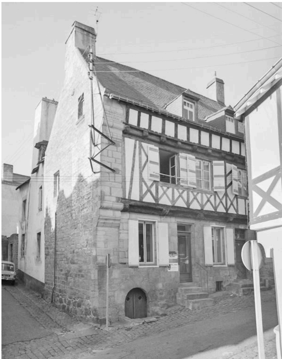
Elévation sur la ruelle avec fenêtre à appui saillant mouluré
