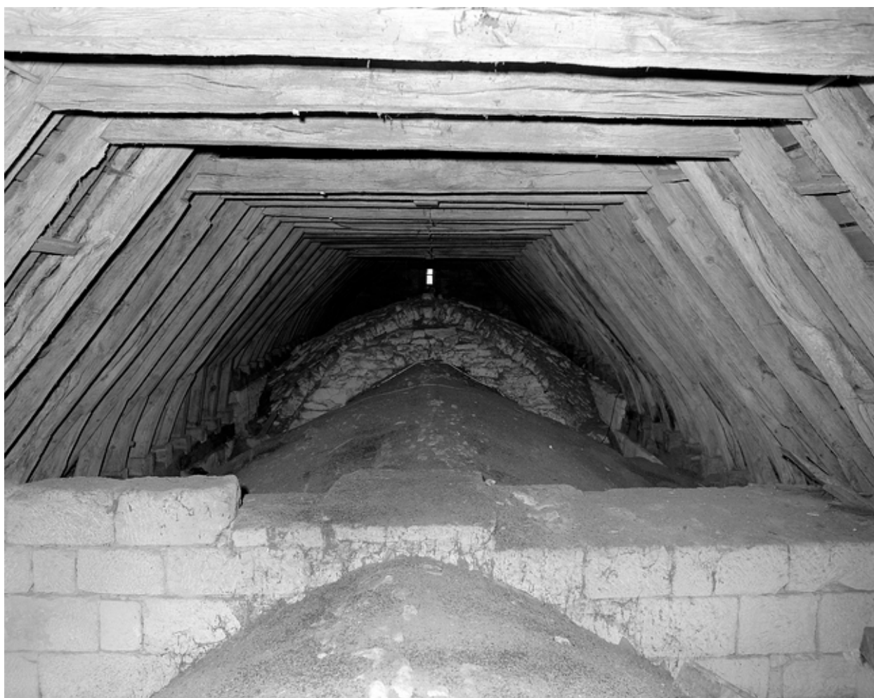
Vue générale de l'extrados des voûtes.
