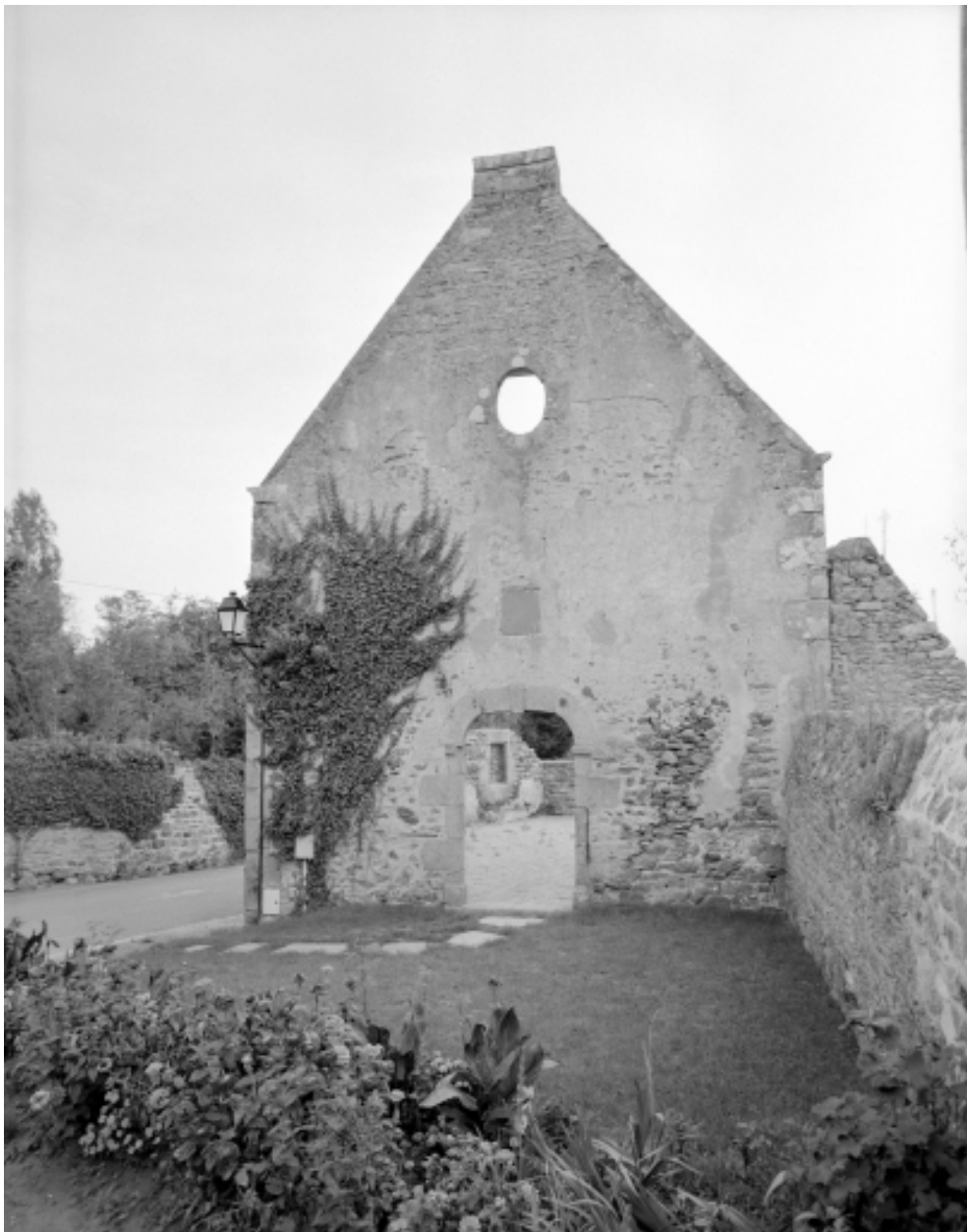
Elévation Ouest : vue générale
