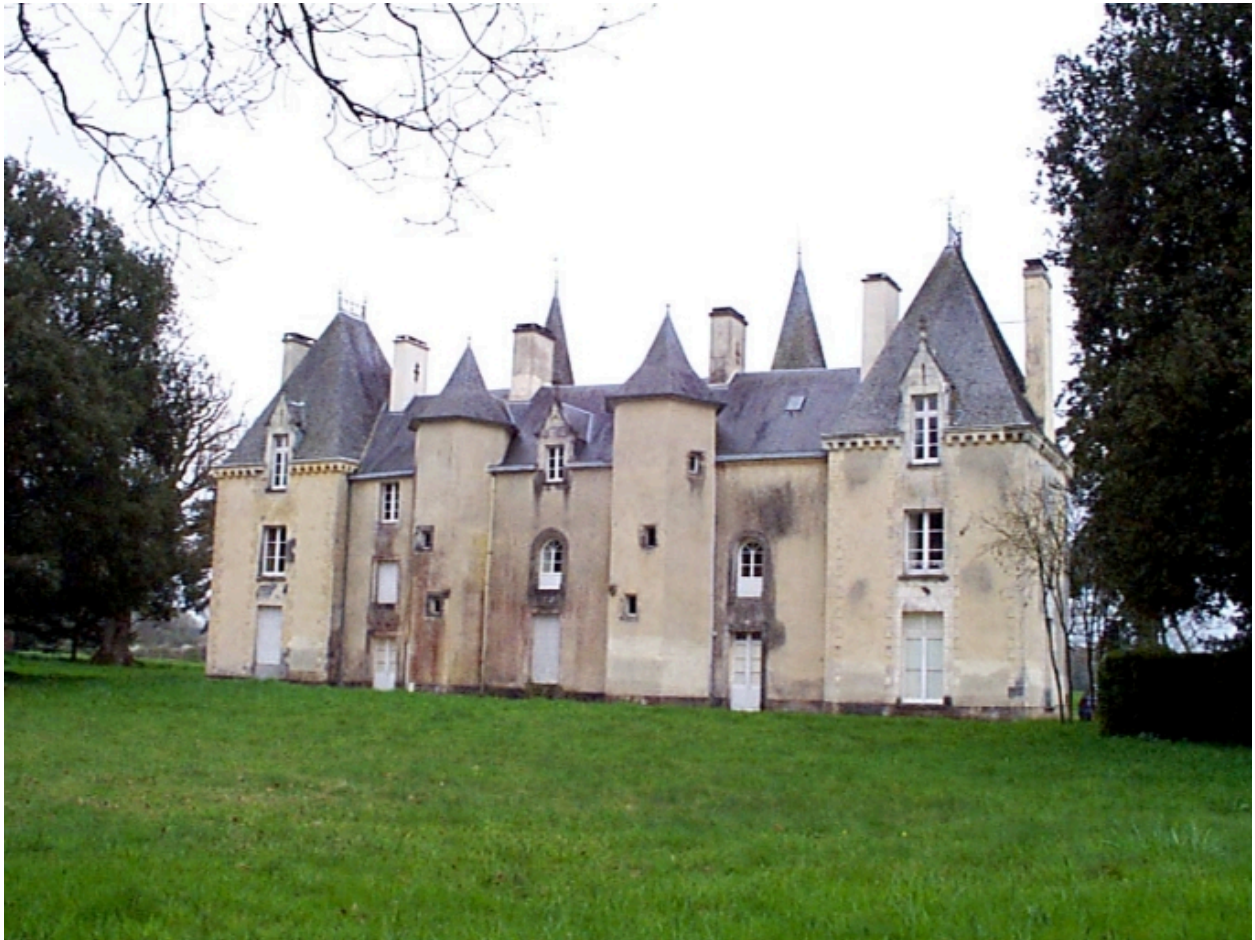
Façade postérieure donnant sur l'étang : vue générale nord-ouest
