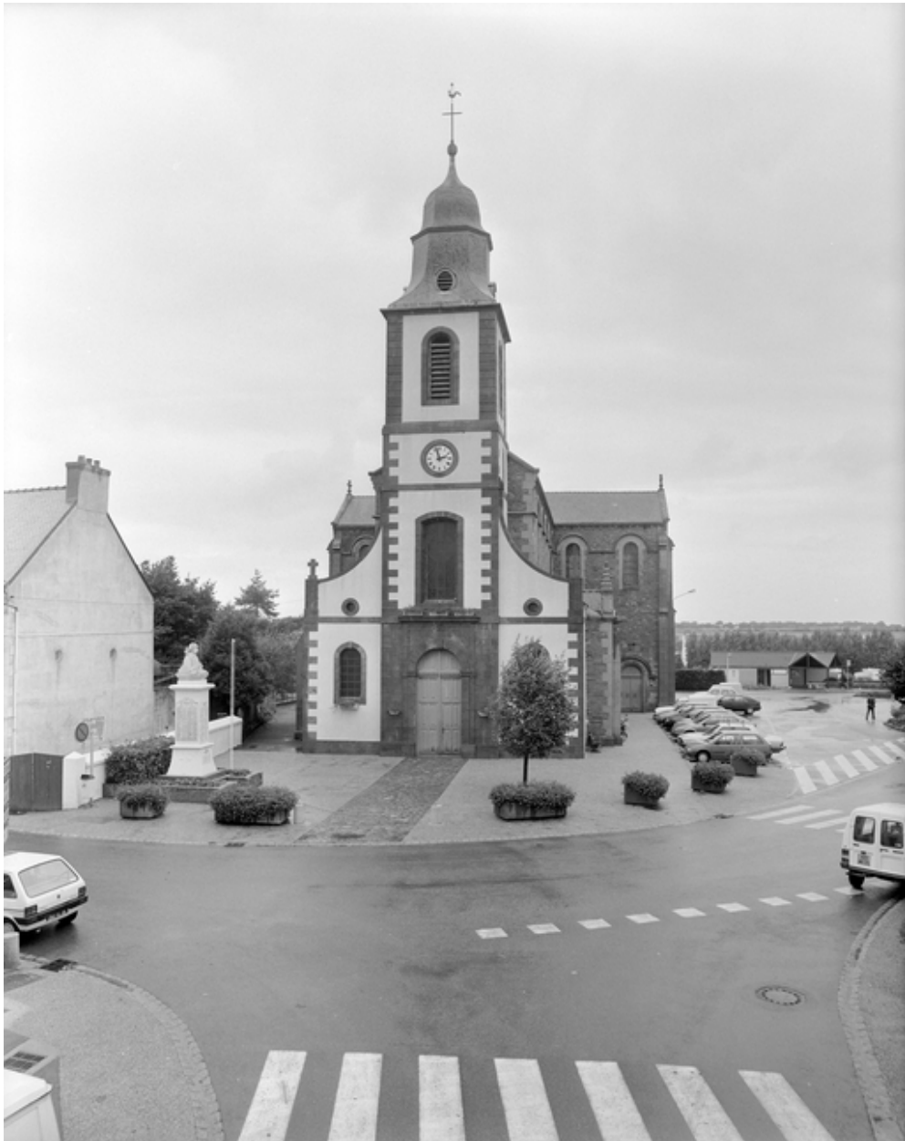
Elévation Ouest : vue générale
