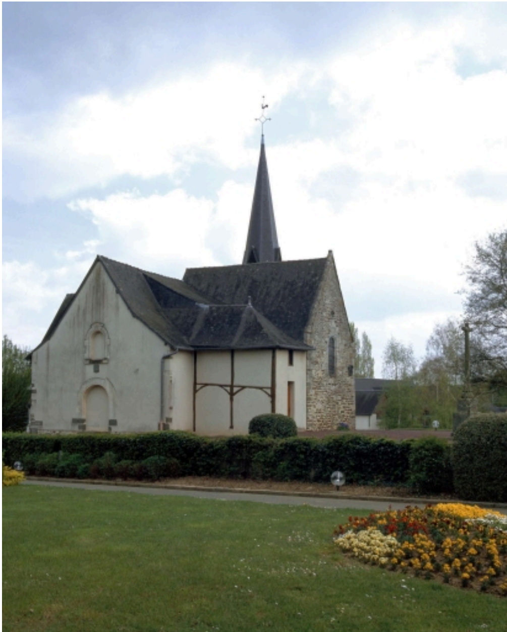
Façade sud-ouest, état après restauration
