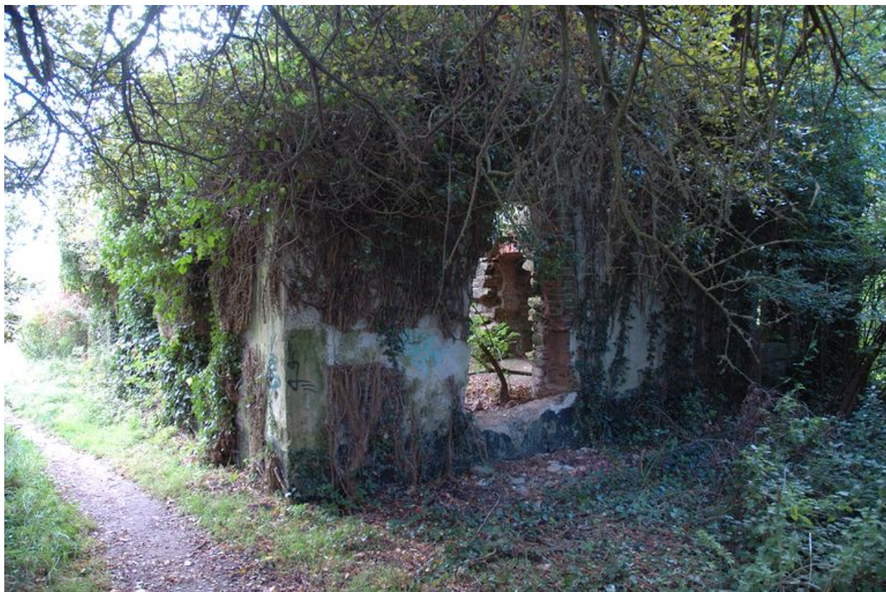
Vue de la caserne (état en 2007)
