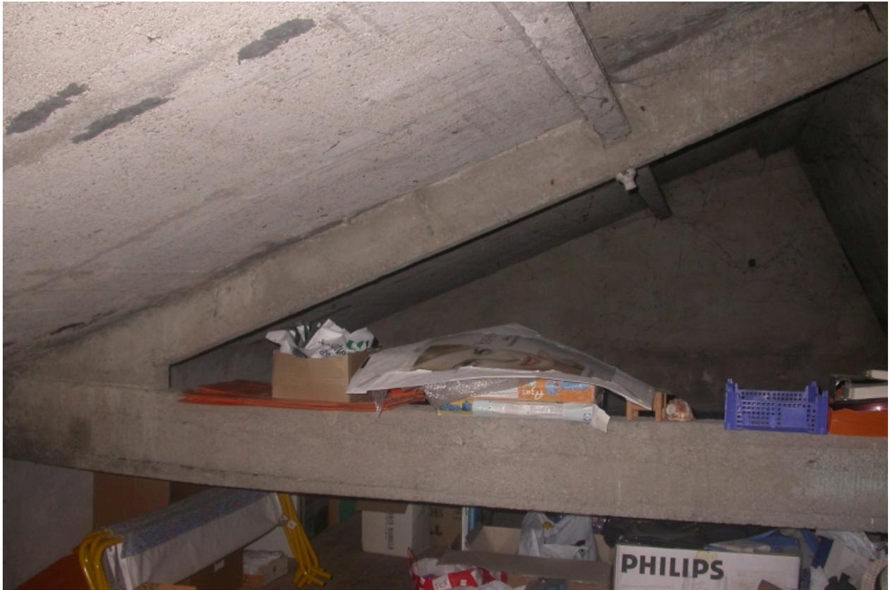
Charpente en béton armé
