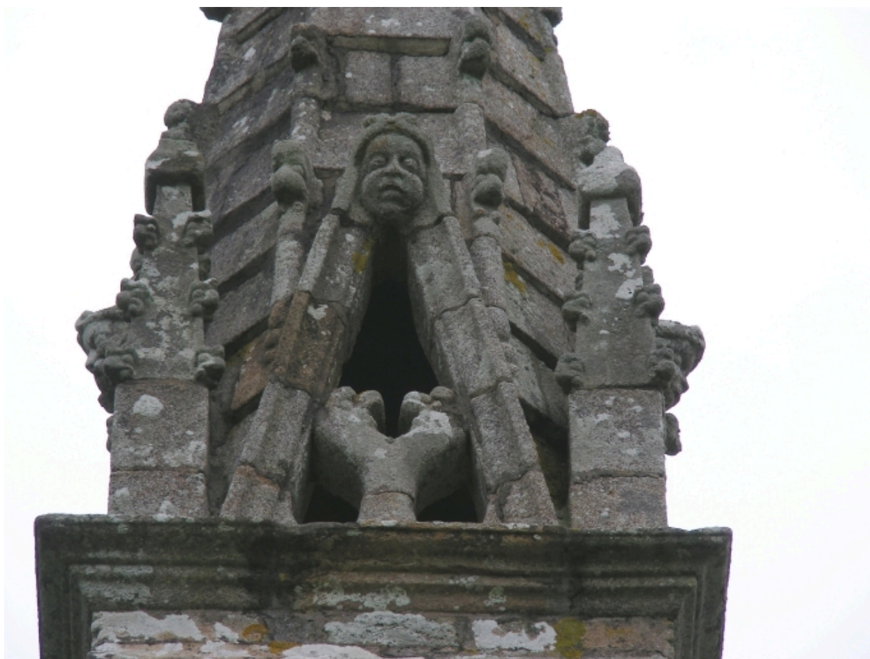
Détail de la face sud de la flèche
