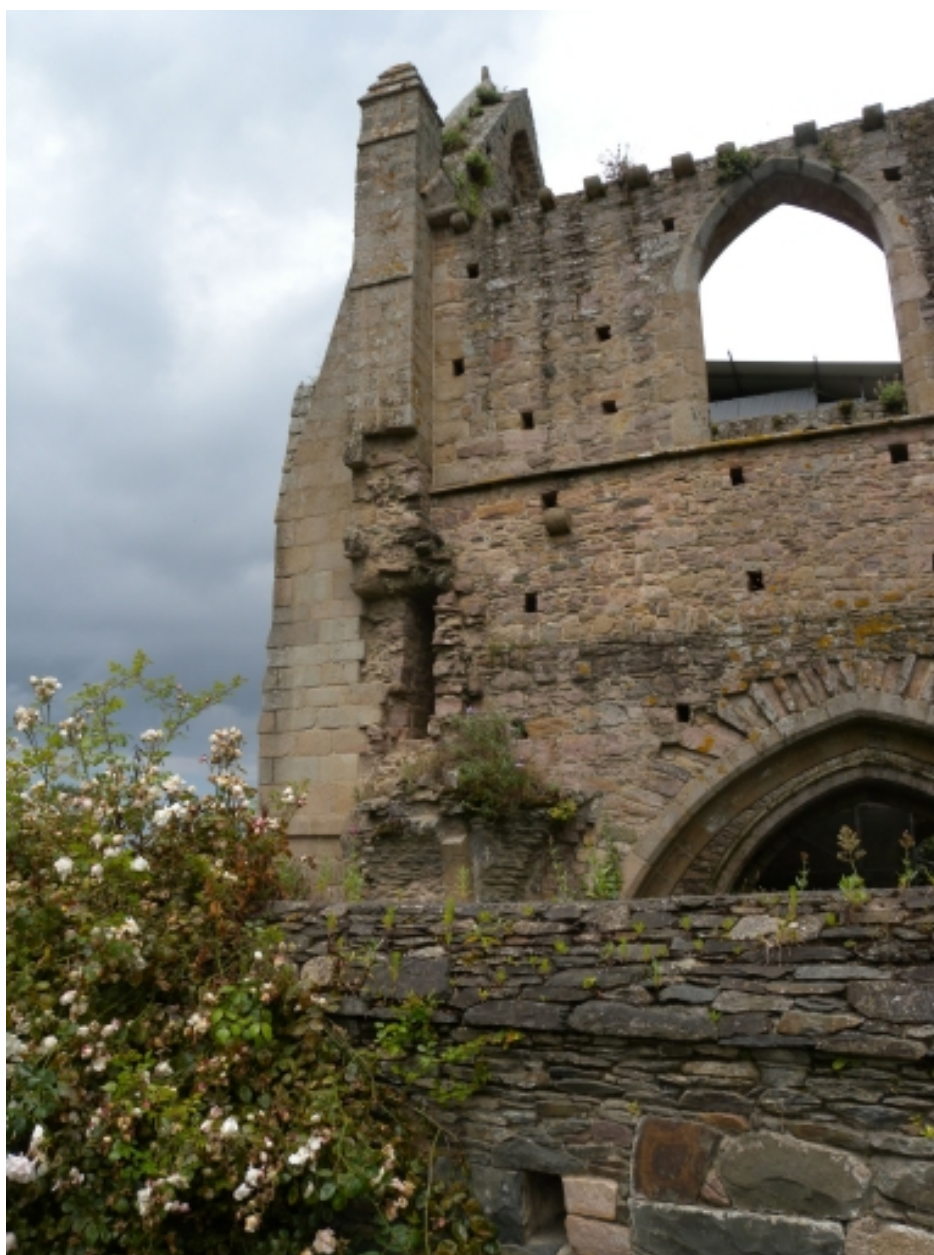
Vue du mur d'enceinte en moellons de schiste à l'Ouest, devant l'église de Beauport
