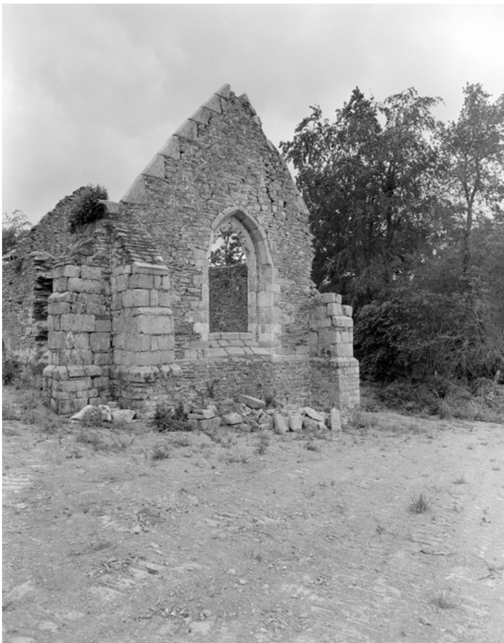
Vue du mur est de la nef
